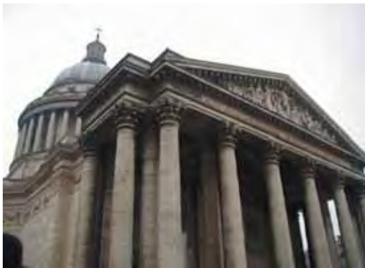
شكل ( ١ - ١٨ ) مدخل مبنى البانثيون - باريس ( ٦ )
