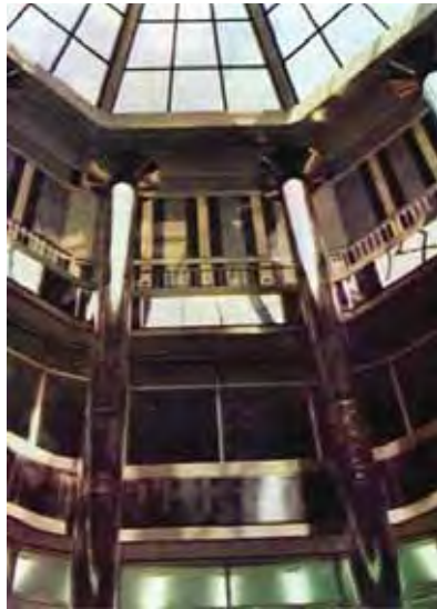
شكل (٣ - ٣) الفناء المثلث ومجموعة الأعمدة المصنعة من الصلب غير القابل للصدأ وتنتهي من اعلي برؤوس علي شكل زهور اللوتس بصورة مجردة
